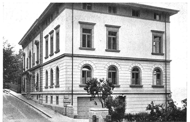
Der neue Anbau am Gebäude des Versicherungsgerichtes in Luzern
