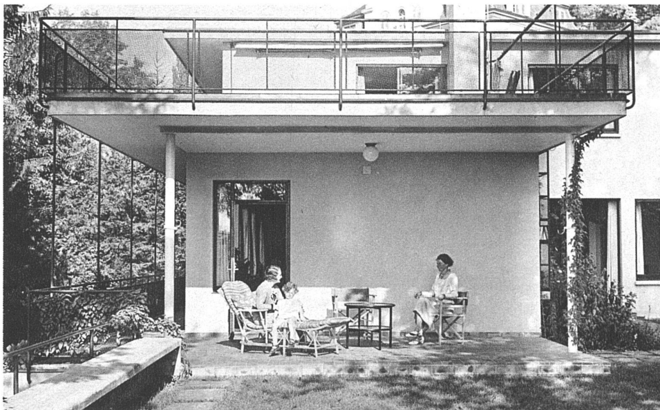
Esszimmervorbau von Südosten
