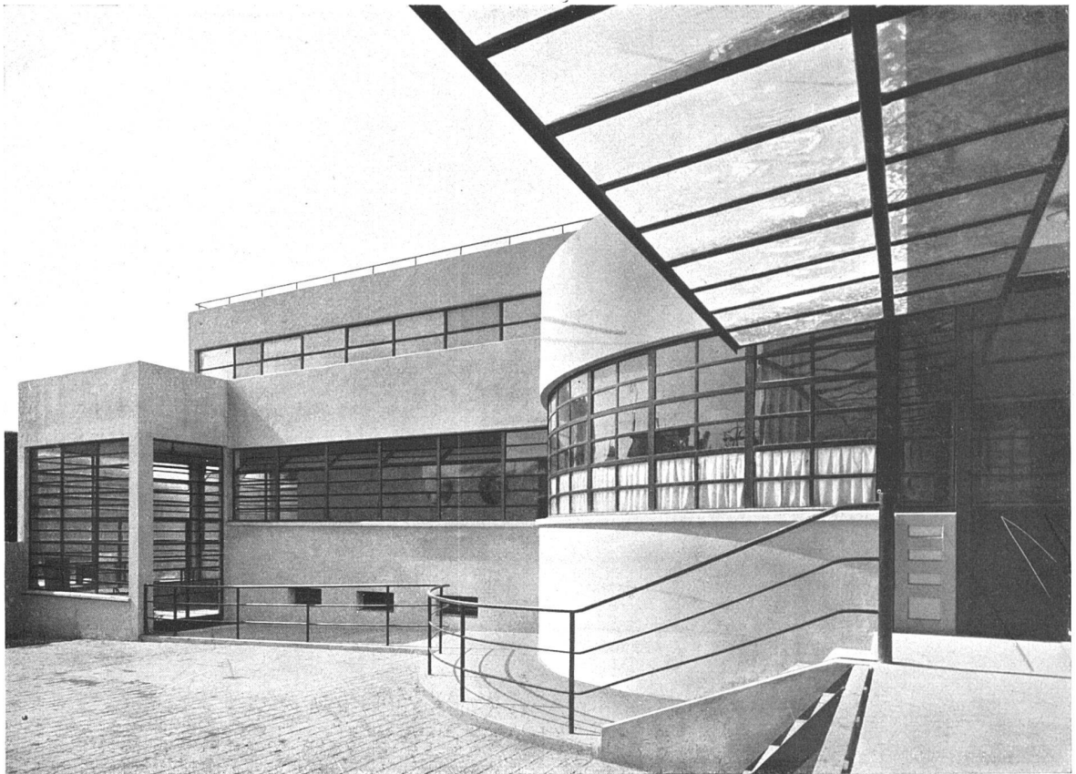
Hof von der Laderampe aus
