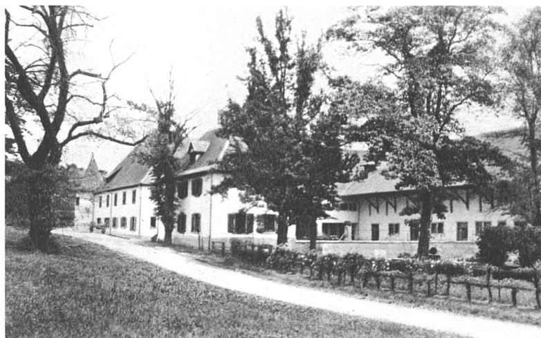
Reconstruction du château d'Ollwiller, près de Sultz (Ht. Rhin) Wavre et Carbonnier, architectes FAS, Neuchâtel
