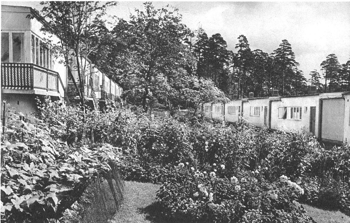
Einstöckige Reihenhäuser, Blick nach Osten
