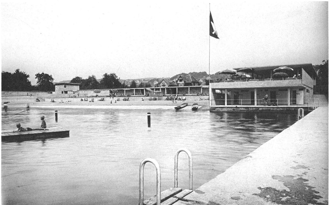
Restaurant, Ausblick nach Süden unten: Ansicht aus Süden, rechts Restaurant
