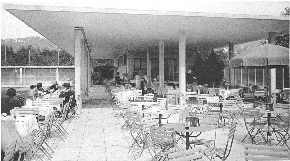
Restaurantterrasse, aus Süden
