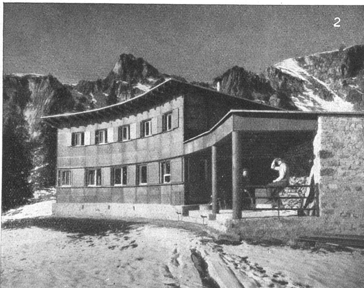
Ski- und Touristenhaus Ortstock über Braunwald. Ardosit-Bedachung (Durotect mit grünem Schieferbelag). Architekt H. Leuzinger, Glarus
