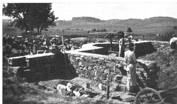
Rohbauaufnahmen, rechts Grundriss 1:200
