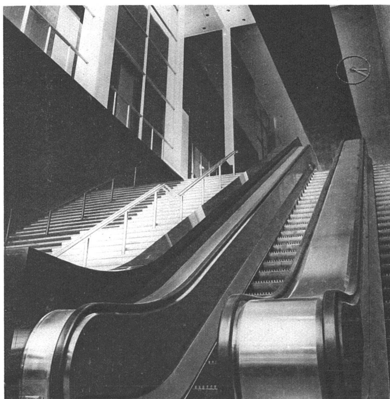
Treppenanlage in der Eingangshalle. Links Glaswand zum Bankraum über einem Sockel von schwarzem Marmor. Die gegenüberliegende Wand ist mit grauem Marmor verkleidet. Decke mit schalldämpfenden Platten belegt, im Mittelstreifen dunkelbraunrot gestrichen. Frontwand über der Stiege schwarzer Marmor. In der Ecke gegen die Bank senkrechte Lichtsäule. Wangen der Rolltreppe und Handläufe der festen Treppe aus rostfreiem Stahl
