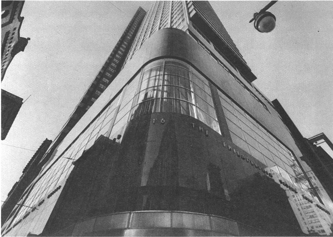
Gebäude der Philadelphia Saving Fund Society, Twelfth Street, Philadelphia Erdgeschoss mit Läden, darüber Bankgeschoss. Fenster 7 m hoch. Wandverkleidung in polierten Granitplatten von 1,20 bis 1,80 m Seitenlänge
