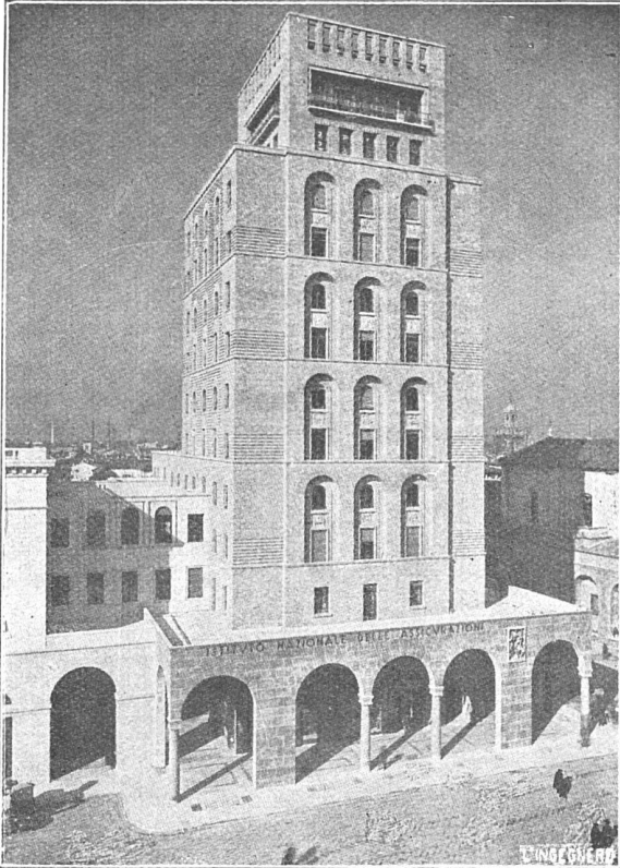
Der grosse Turm des nationalen Versicherungsinstitutes Höhe 57,25 m — La grande tour de l'Institut national d'assurances, vue de l'est
