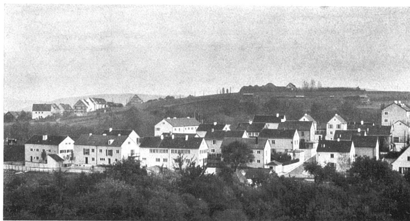
Ansicht von Norden, im Vordergrund die Doppel­häuser 16/15, 14/13, 12/11 des Lageplans, rechts oben das grosse Gebäude Nr. 4 von Prof. Bonatz
