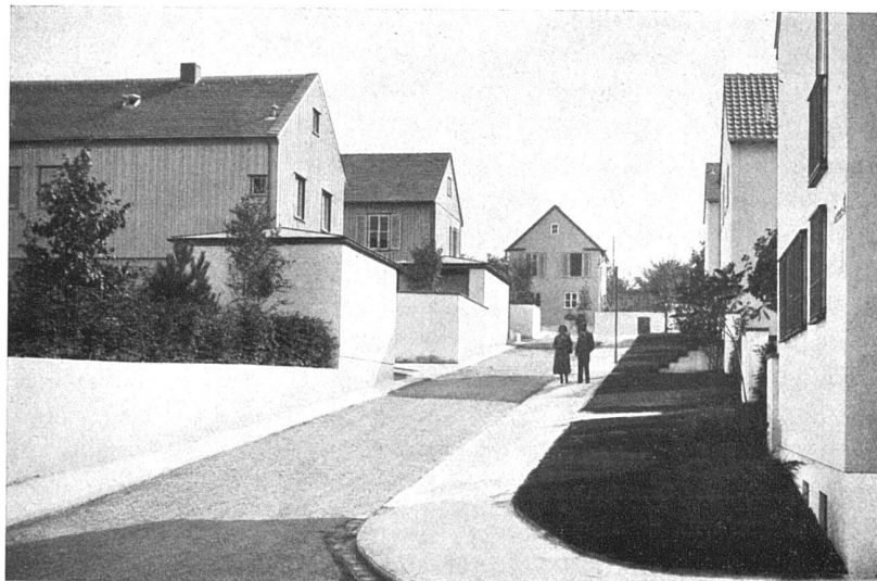
Links die Häuser 20 und 21, aus Nordwesten gesehen, mit massiven Garagen und Garten­mauern, im Hintergrund Giebel von Haus 24, rechts die Häuser 9, 7, 5
