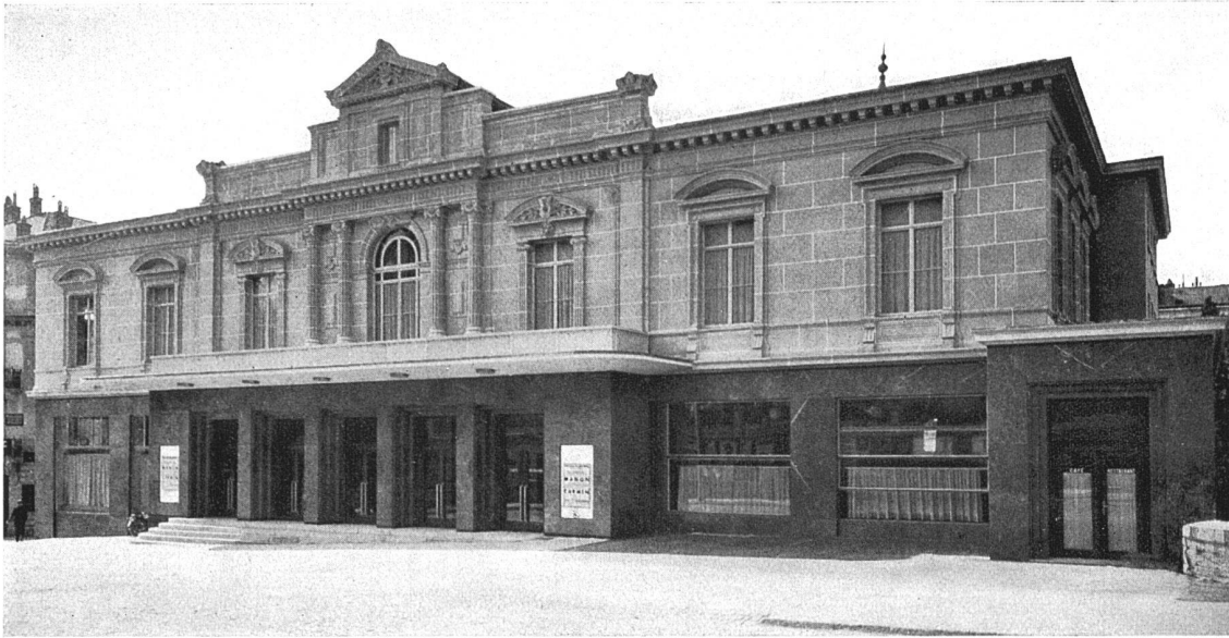
Théâtre municipal de Lausanne Entrée principale de l'avenue de la Gare, ancienne façade renovée Die bestehende Fassade wurde im Erdgeschoss mit Marmorplatten verkleidet
