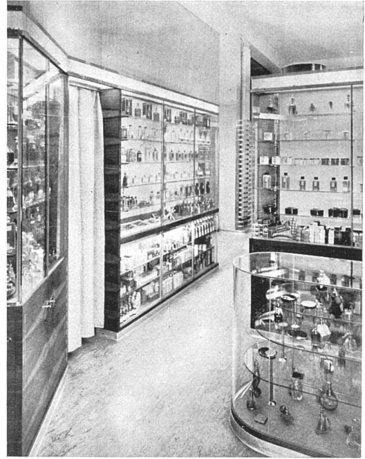
Parfumerieladen in Lausanne Kaukas. Nussbaum, Vitrinen staubdicht abgefilzt, rahmenlose Glasecken, mit Innenbeleuchtung
