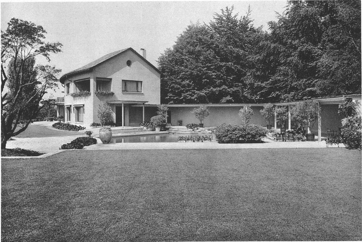
Ostseite, Schwimmbassin und Wandelhalle
