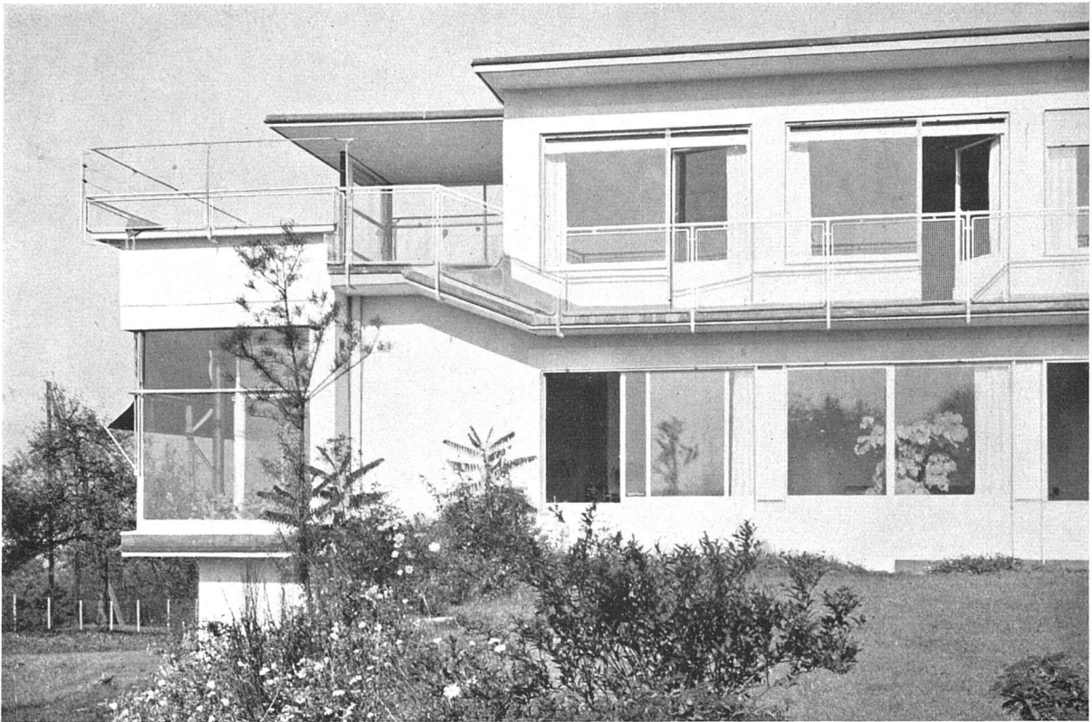
Teilansicht der Südostfassade, links das grosse Blumenfenster; der südwestliche Teil des Wohnzimmers ist 40 cm höher als die anderen Erdgeschossräume, deshalb die Differenzstufen im Laubengang des Obergeschosses
