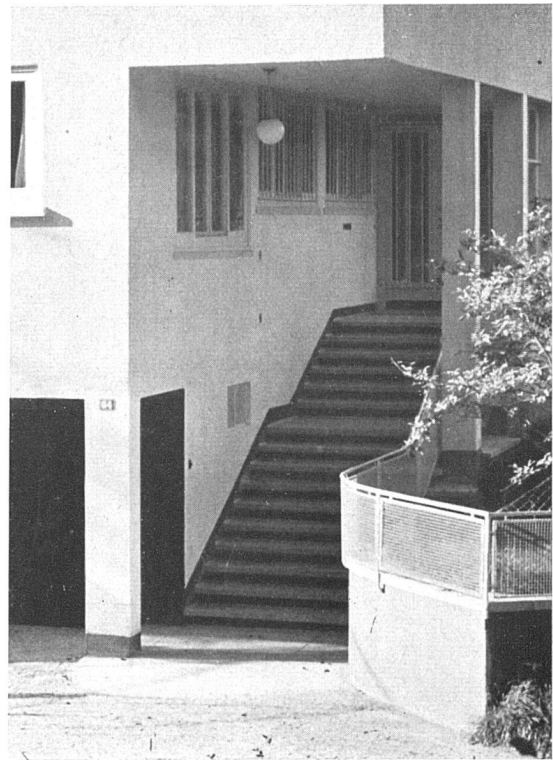
Haupteingang an der Nordecke, im Untergeschoss Garage
