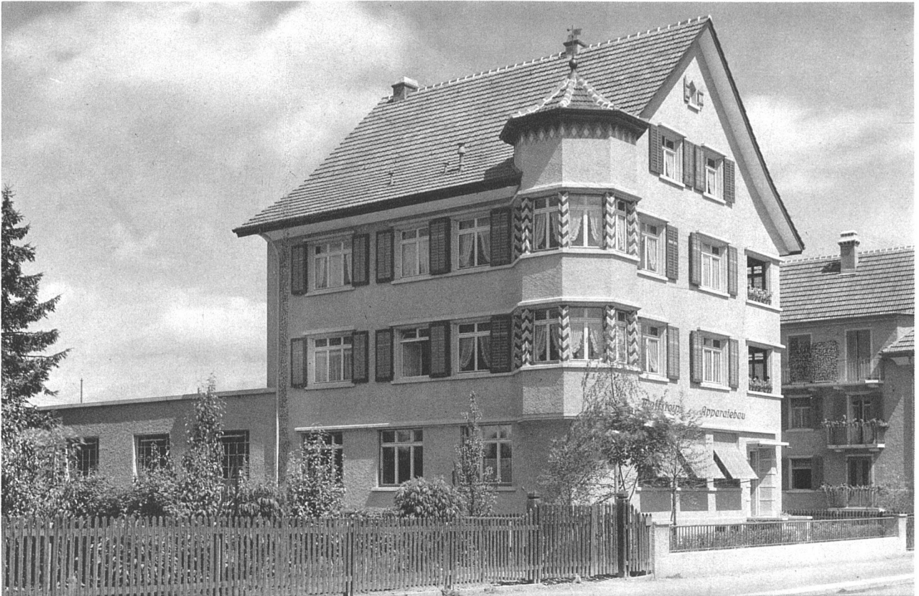
Karl Scheer, Architekt BSA, Oerlikon-Zürich. Wohnhaus und Werkstatt in Oerlikon. Erbaut 1926
