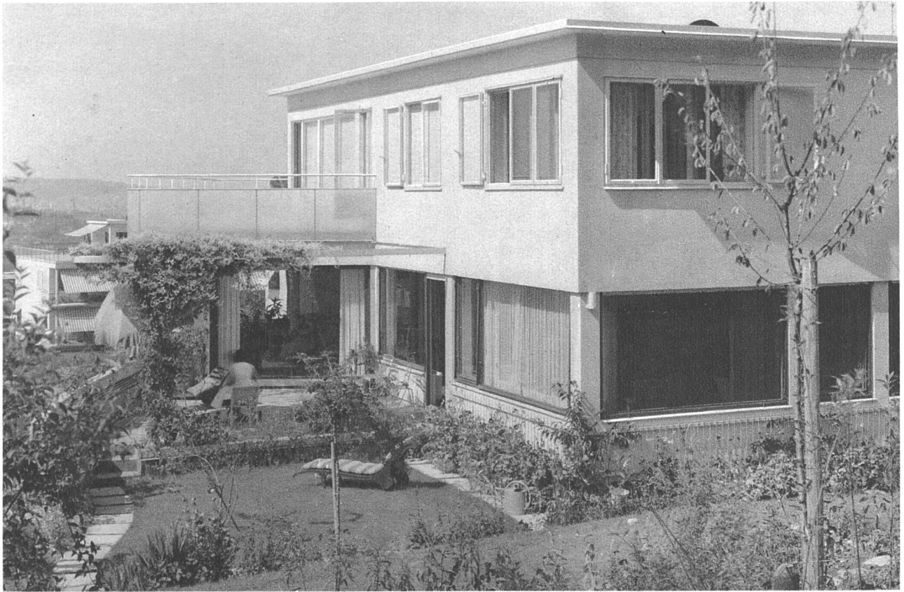
William Dunkel, Architekt BSA, Professor E. T. H., Zürich. Wohnhaus des Architekten. Erbaut 1932—33
