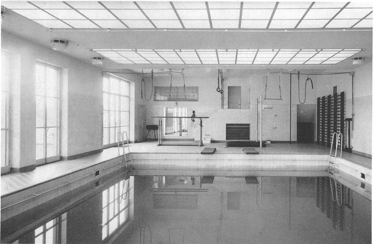
W. Schwegler mit G. Bachmann, Architekt BSA, Zürich. Schwimmbad in einem Landhaus in Erlenbach
