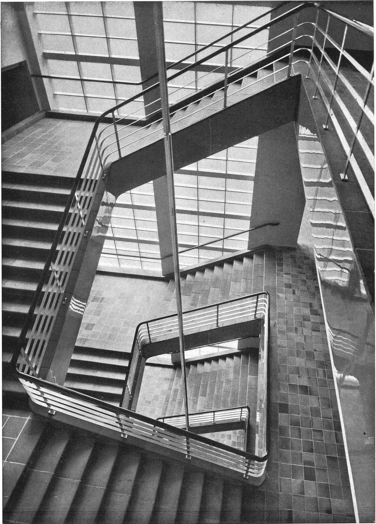
Haupttreppe im Lehrgebäude des Maschinenlaboratoriums. Stufen und Podestbodenbelag aus braunen Klinkern, seitliche Treppenwange gespachtelt und hochglanzblau gestrichen. Als Beleuchtung eine «Linestra»-Röhrenkette durch alle Stockwerke
