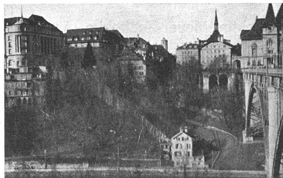
Ansicht der Baustelle vor Inangriffnahme der Arbeiten, rechts Kasino, links Bellevuehotel, Mitte die abzubrechenden Gerbergrabenbauten und ein Stück der alten Stadtmauer, die bleibt
