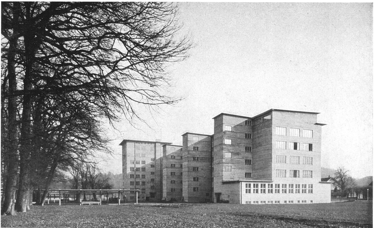
Ansicht von Nordwesten, links der «Eichwald» und die offenen Putzhallen
