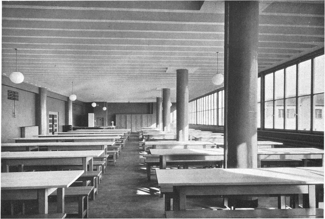
Mannschaftssaal. Durch die Faltfenster werden diese Räume im Sommer in offene Hallen verwandelt
