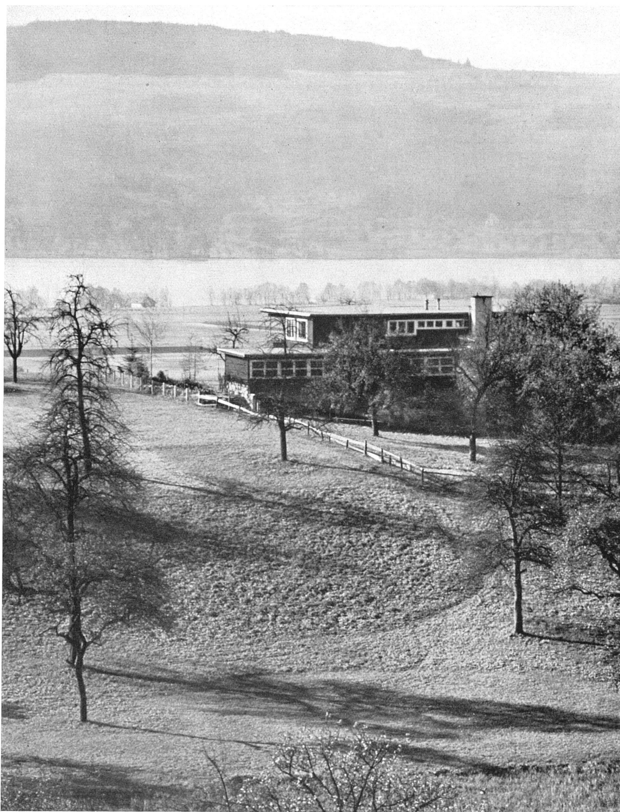
Keramische Werkstätte F. Haussmann, Uster (Kt. Zürich), erbaut von Max Ernst Haefeli, Arch. BSA, Zürich Ansicht von Osten gegen den Greifensee
