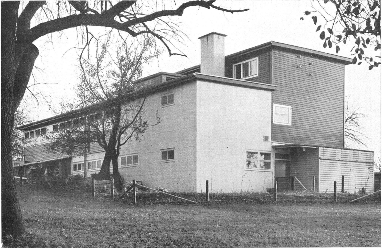
Ansicht von Norden. Links Werkstatt, im unverputzten Betontrakt die Brennöfen, im Anbau rechts Rohstoffvorräte Keramische Werkstätte F. Haussmann, Uster (Kt. Zürich) Max Ernst Haefeli, Architekt BSA, Zürich
