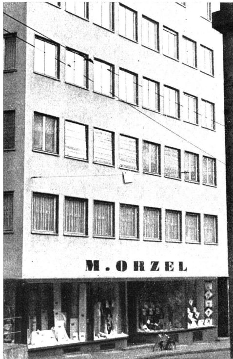
Wohn- und Geschäftshaus Orzel, Basel Fassade gegen den Blumenrain Schaufenstereinrichtung in Dornametall
