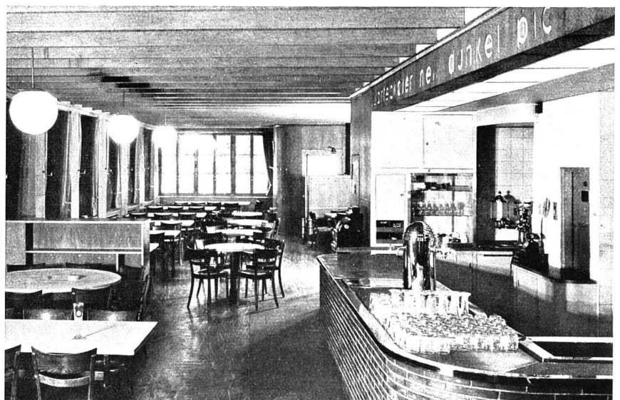
Innenraum des Restaurants, gegen Westen
