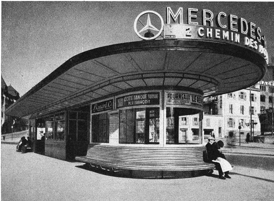
Strassenbahn-Wartehaus, Place Chauderon, Lausanne. Dachuntersicht aus ebenen Eternitplatten mit Eternitdeckleisten
