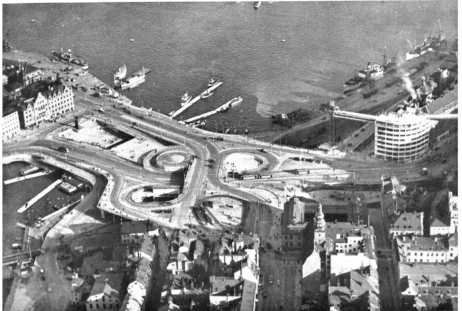
Stockholm, Schleuse («Slussen»). Scheide des Binnenwassers vom Salzwasser (Höhenunterschied ca. 3 m). Verbindungsknoten der Altstadt mit den neuesten Stadtteilen. Kreuzung der Schifffahrtslinie, Eisenbahn, Strassenbahn, Automobilstrasse und Fussgängerweg. Konstruktion: sogenannte Kleeblattform (Cloverkaparrangement). Architekt: Tage Wiliam Olsson
