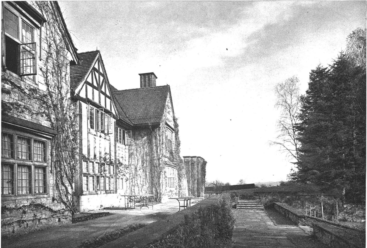
Blick entlang der Südfassade nach Osten. Fachwerk aus Eichenholz. Tuff-Mauerwerk
