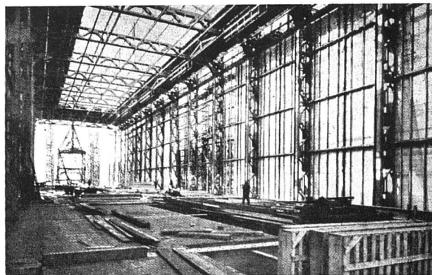
Der deutsche Pavillon als Skelettbau. Er wirkte vor seiner Verkleidung mit Steinplatten bei weitem grosszügiger, luftiger, eleganter
