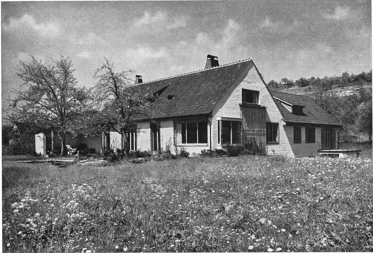
Ansicht aus Süden
