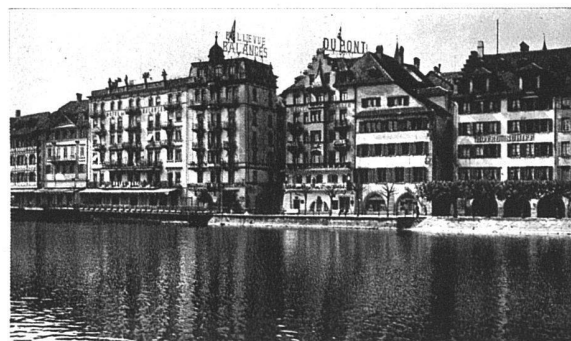
Das rechte Ufer der Reuss, in seiner heutigen Gestalt. Die zahlreichen Umbauten der schlichten Bürgerhäuser haben an vielen Orten zu einer kaum mehr zu überbietenden «Intensivierung» der einst so ruhigen Dachkörper geführt
