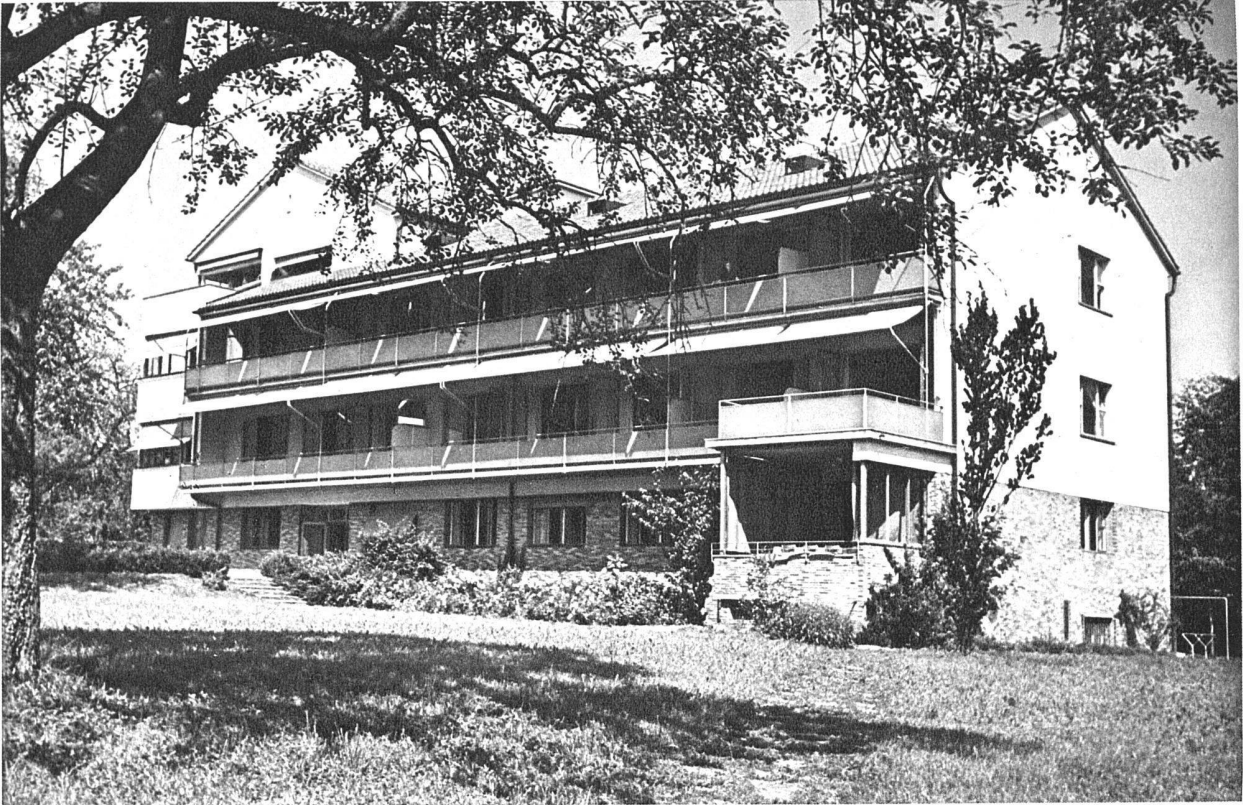
Ansicht aus Südosten
