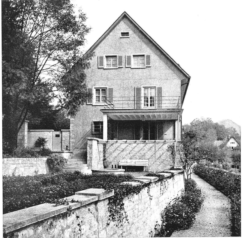
Ansicht aus Südwesten
