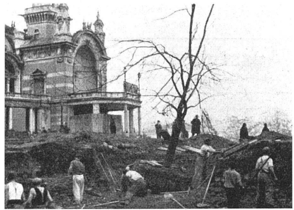
Beginn des Abbruchs und Aushubs am 25. Oktober 1937, am Tag, nachdem die erforderlichen Mittel durch Volksabstimmung bewilligt wurden
