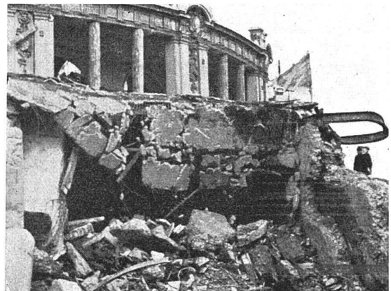
Entfernen der Terrasse des Tonhallerestaurants Die Höhlen im Vordergrund sind die grossen Zuluftkanäle
