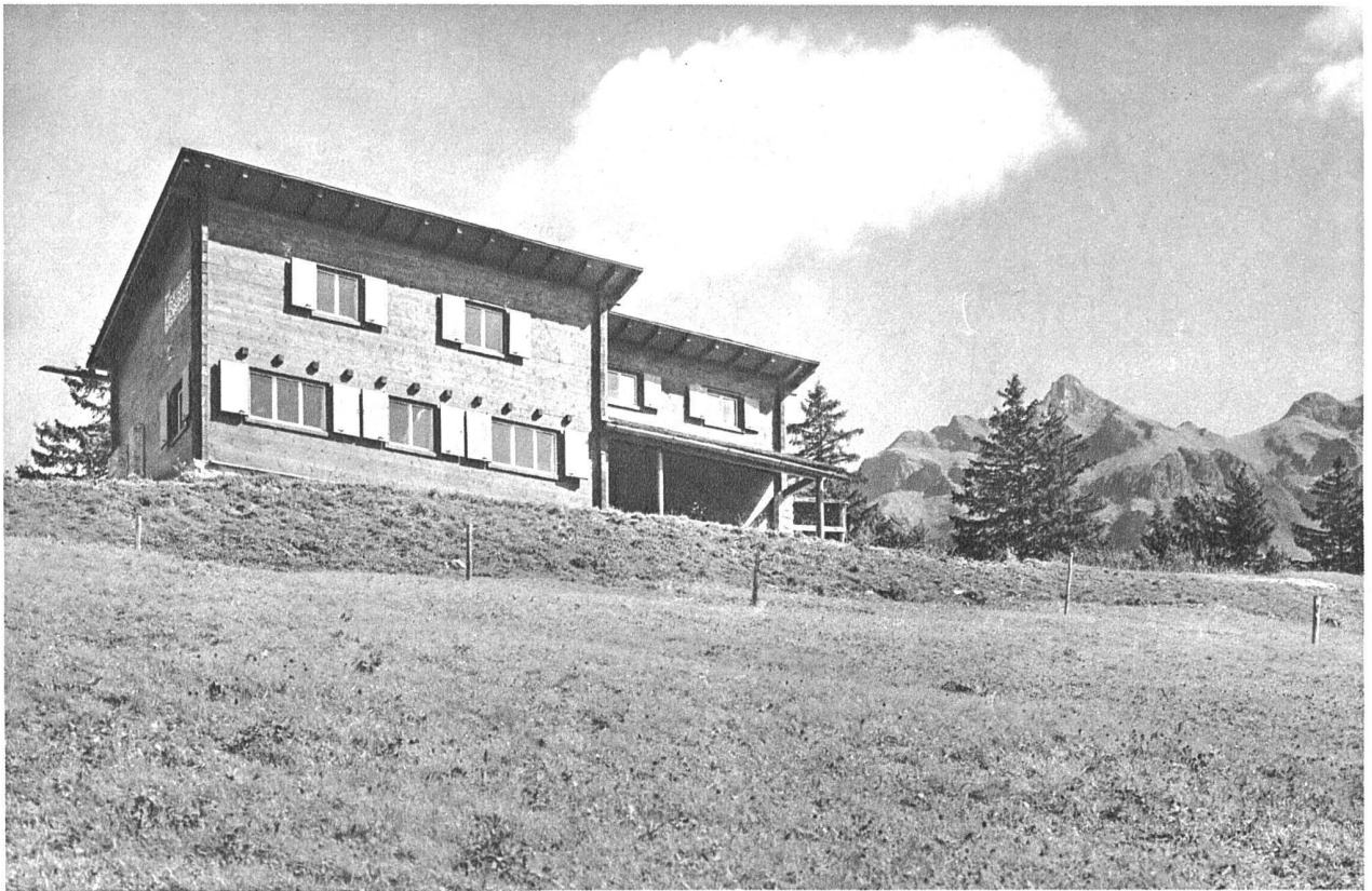
Skihaus Oberfeld der Sektion Gotthard SAC, bei Altdorf (Uri) Architekten A. H. Steiner BSA, Zollikon (Zürich) und Max Meier, Zürich
