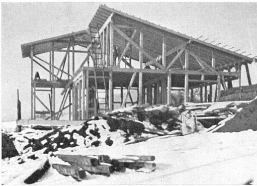
Der Rohbau von Osten. Bauzeit: Februar bis April 1934 Aussenaufnahmen: Jansky, Bern Innenaufnahmen: E. Keller, Bern
