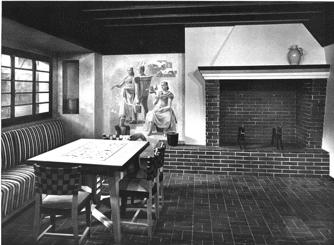
Chambre commune pour week-end dans la Gruyère
