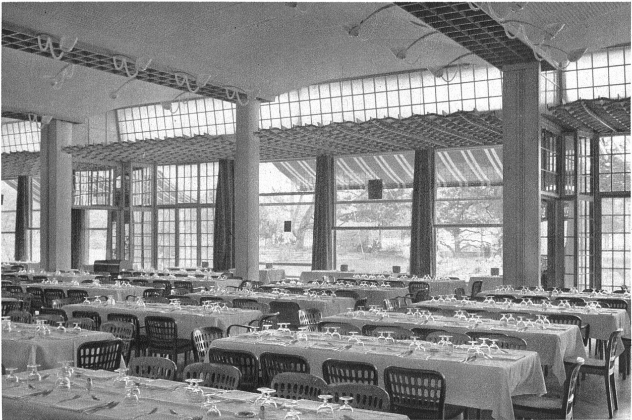
Gartensaal, Blick gegen Vorgarten und Alpenquai, gelochte Gipsplatten zugleich als Schalldämpfung und Oberflächentextur.
