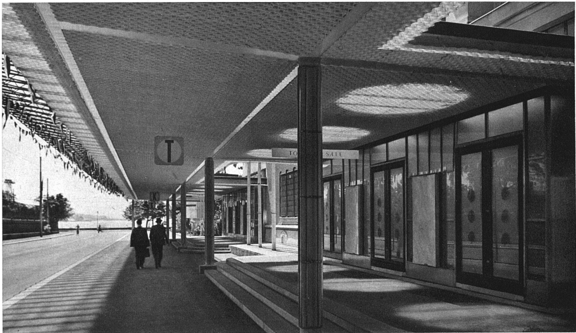
Vordach Clariden-Strasse; von der Wand des Altbaus 9,5 m, von den Stützen an noch 5,5 m frei vorkragend. Als Oberflächentextur der Untersicht Roste aus verschränkten gewellten Blechbändern. Türumrahmungen in schwarzem Eichenholz, Wandfelder Milchglas in Bronzerahmen.
