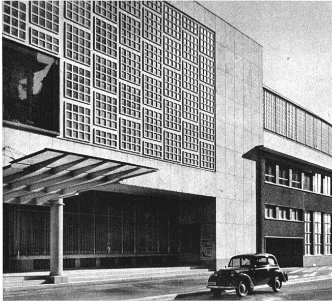
Kongresshaus Zürich M. E. Haefeli, W. M. Moser, R. Steiger Architekten BSA, Zürich
