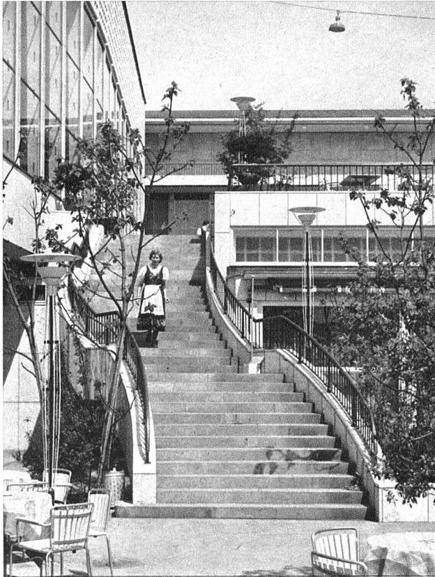
Geschweifte Treppe zur Restaurantterrasse über dem Gartensaal.
