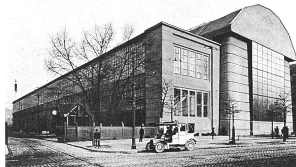
Turbinenhalle der AEG., Berlin-Moabit, Ecke Hutten- und Berlichingenstrasse, 1909. Maschinenmonumentalität
