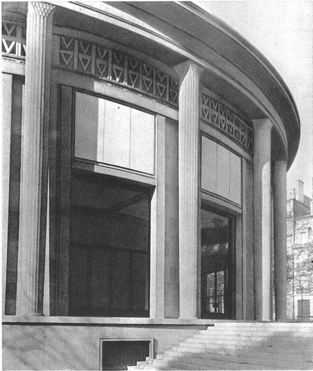
Auguste Perret: Musée des Travaux publics, Paris
