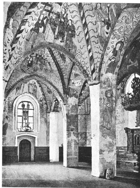
Kirche von Hattula bei Tavastehus (Hämeenlinna). Malerei vom Ende des XV. Jahrhunderts. Typische Hallenkirche: drei gleich hohe Schiffe unter einem Dach wie unten die Kirche von Sibbo. In Finnland, Schweden und Dänemark sind mehrere Kirchen dieser Art mit ähnlicher Ausmalung erhalten
