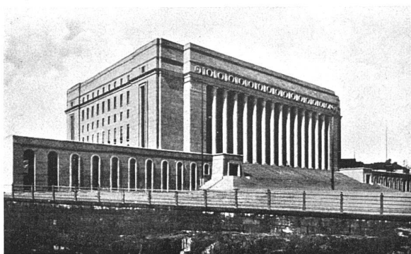
Arch. Prof. J. S. Sirén: Parlamentsgebäude in Helsingfors, erbaut 1931 in Granit
