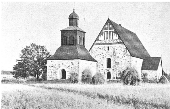
Kirche von Sibbo bei Helsingfors aus Südwesten. Steinerne Hallenkirche mit freistehendem Glockenturm und typischer Giebelbildung mit Backstein und weissen Putzfeldern, innen Reste von Malerei wie vorhin, 1935 von der finnischen Denkmalpflege sorgfältig wiederhergestellt
