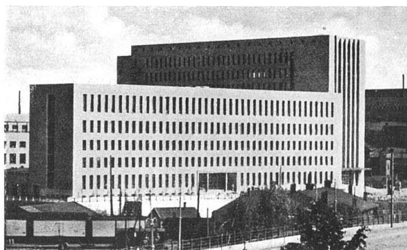
Architekten E. und E. Lindroos und K. Borg. Hauptpostgebäude Helsingfors in der Nähe des Bahnhofs, erbaut 1936—1939. Klinkerfassaden
