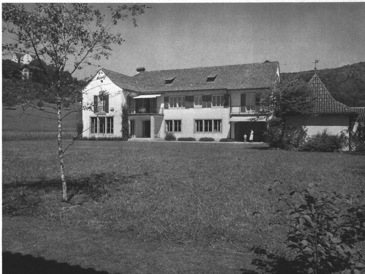
Gartenseite, Ansicht aus Süden. Dieser Bauflügel enthält die Wohn- und Schlafräume der Familie.
