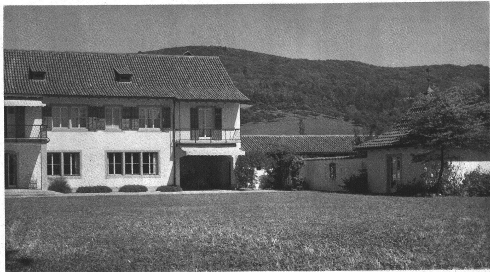
Ansicht aus Südwesten, rechts die Mauer des Blumengartens
