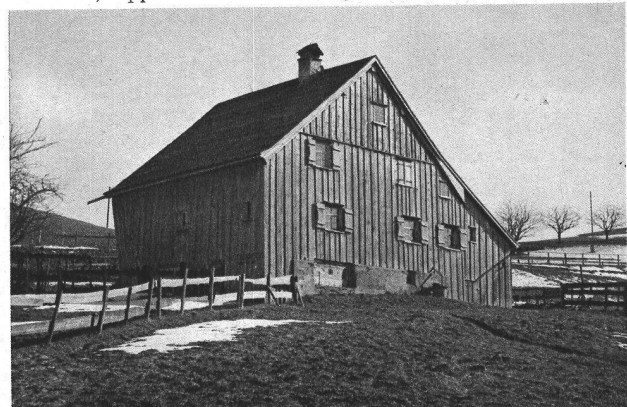
Leistenschirm, Rückfront (Nordwestseite) eines Wohnhauses in Stein, Appenzell. Niederschlagsmenge 1,35 m
