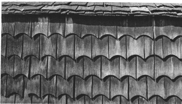
Handgespaltene Schindeln mit Segmentschnitt Schindelschirme sind vor allem in der Ostschweiz eine beliebte und bewährte Aussenhautverkleidung
