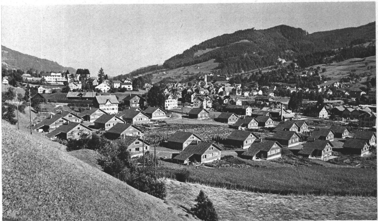
Ansicht aus Süden
