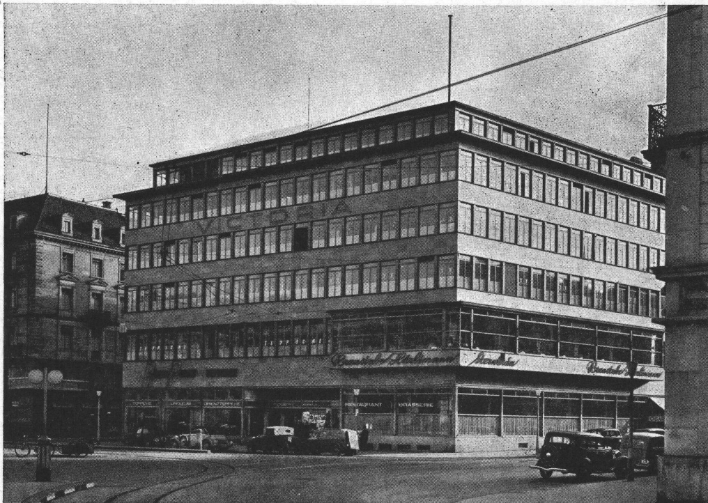
Stahltragwerk im Hochbau: Viktoria Zürich
