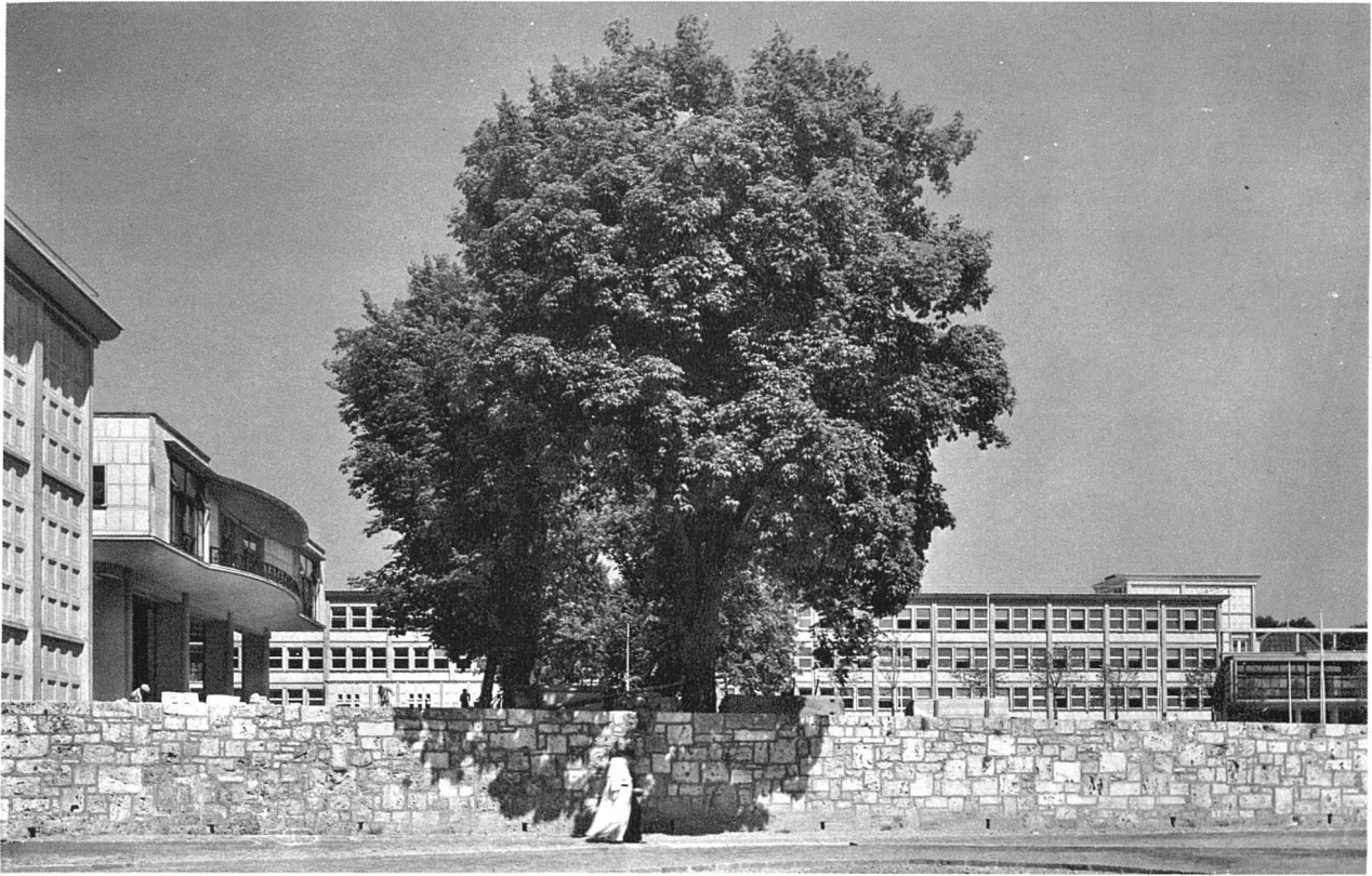
Gesamtansicht von Südosten: links Kollegienhaus, Haupteingang, im Hintergrund der Seminartrakt
