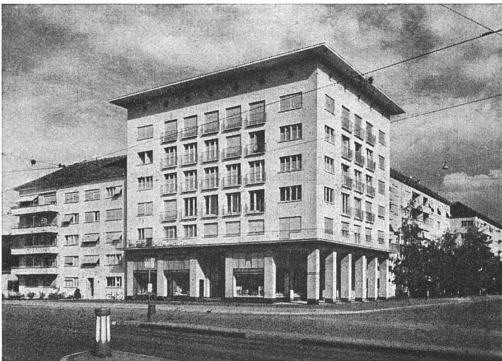
Geschäftshäuser «Zum Korn» (Gemeinschaftsausführung)
