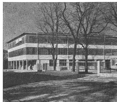
Neubau der Nationalzeitung in Basel
