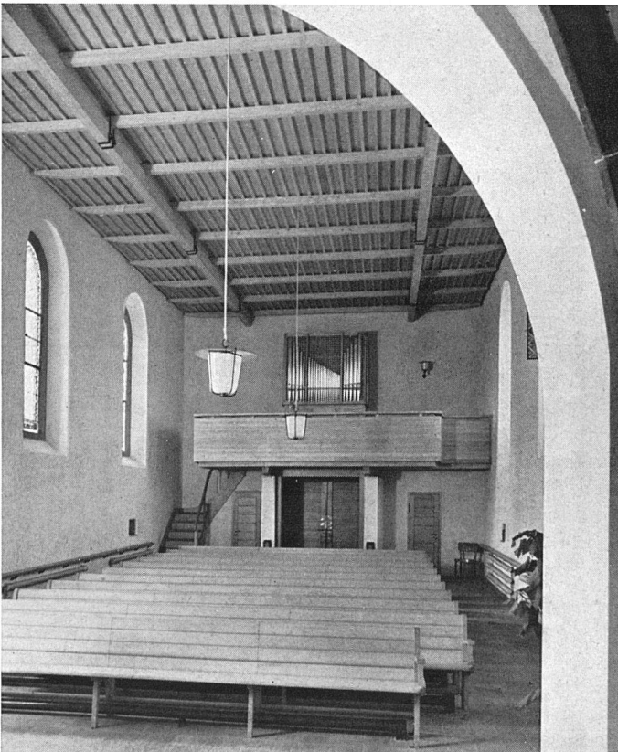
Abb. 20 Renovierter Innenraum der alten Kirche
