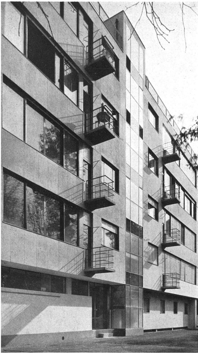
Vestfassade mit Treppenhaus
