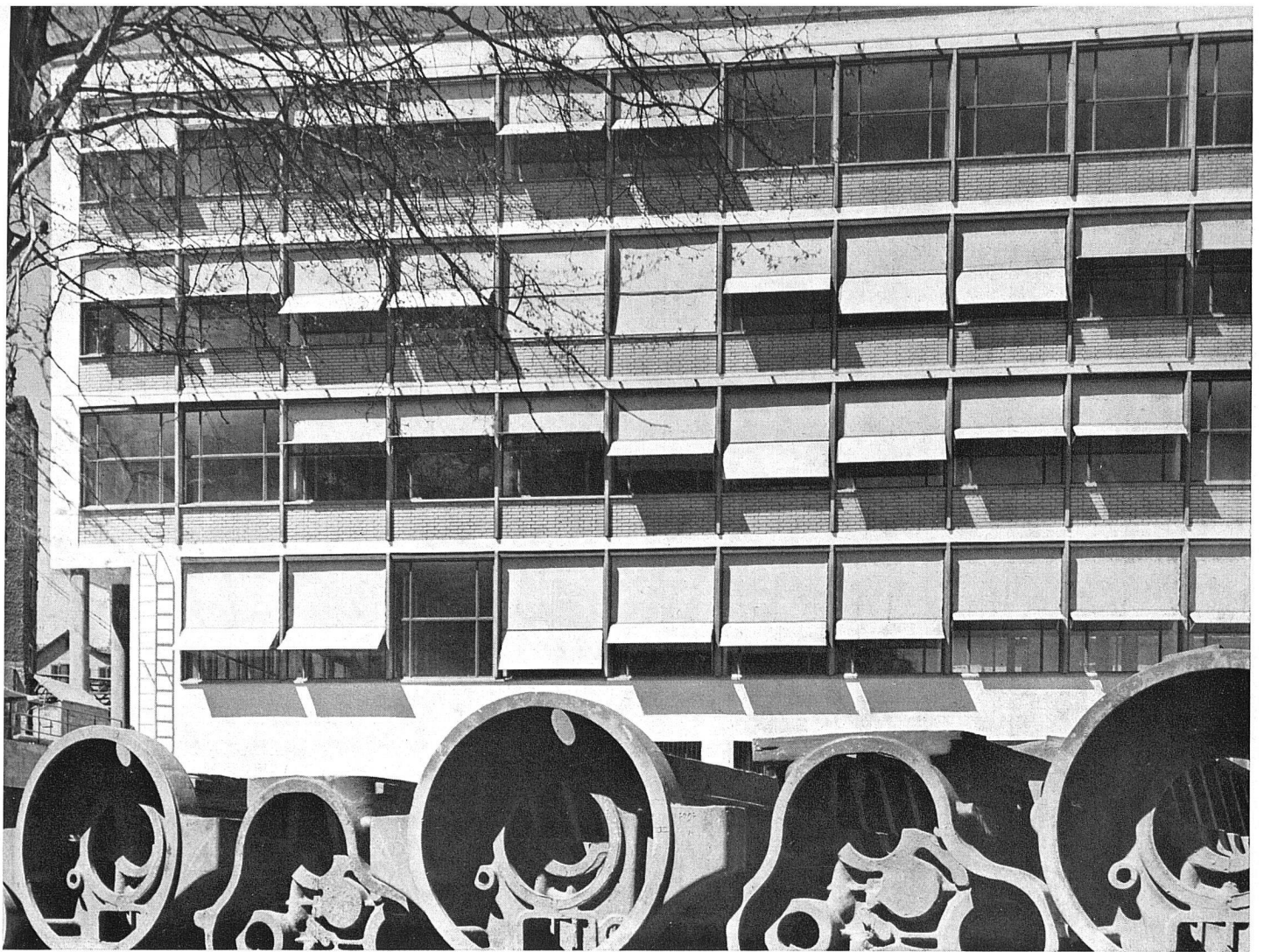
Südostansicht vom Werkhof aus, im Vordergrund rohe Gußbestandteile
