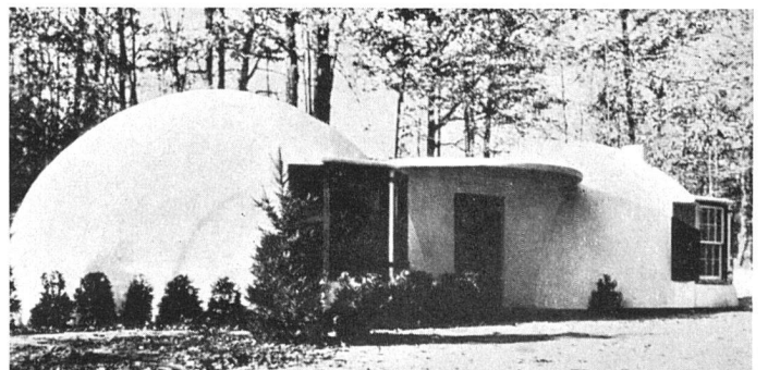
Abb. 10 Amerika. Behelfsheim in Spritzbeton mit Ballonschalung
