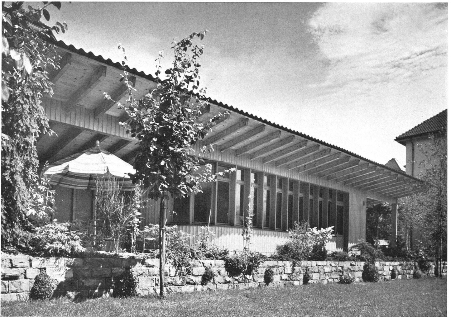
Gesamtansicht vom Garten gesehen
