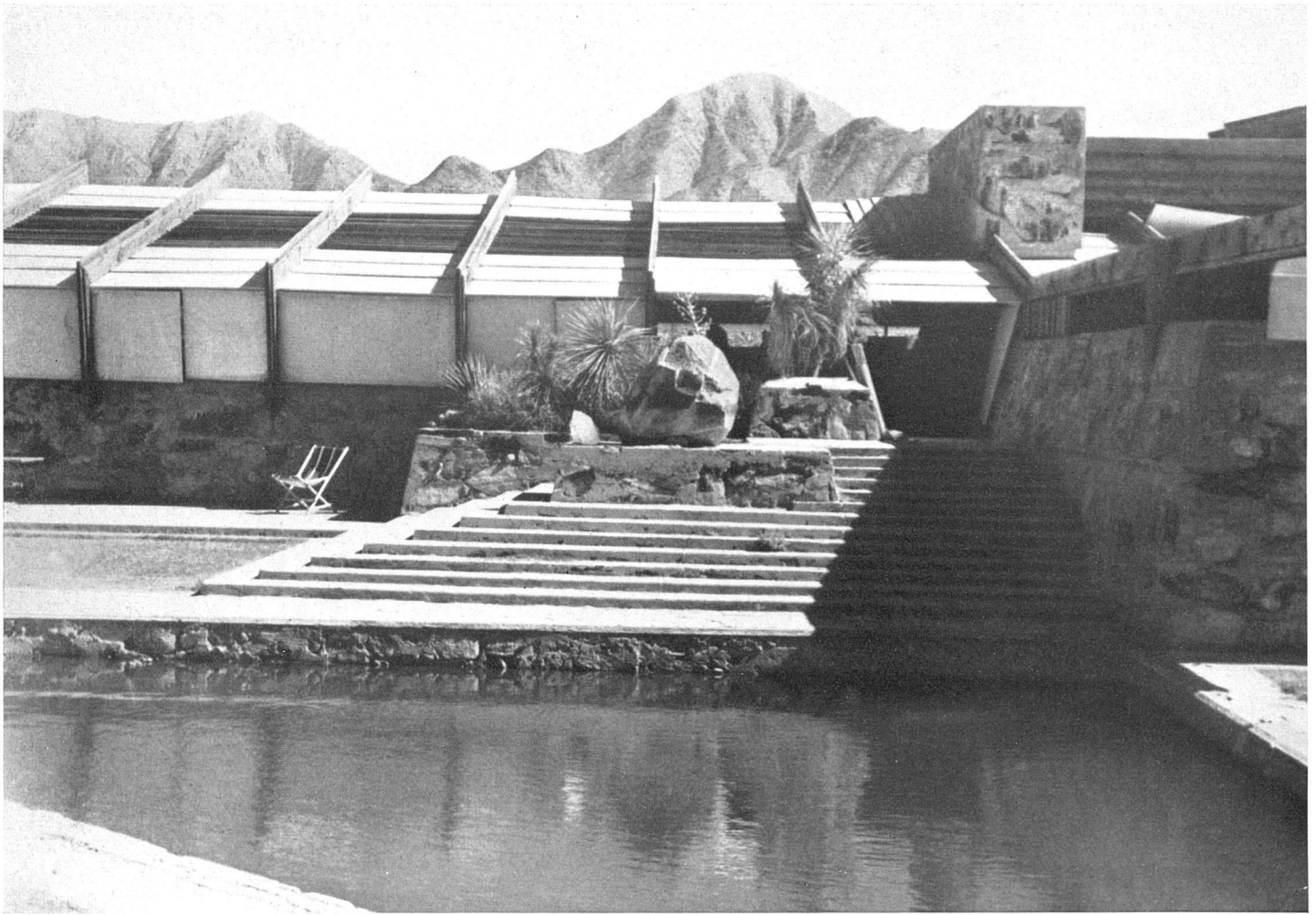
Frank Lloyd Wright Taliesin West in Maricopa Mesa, Paradise Valley, Arizona, 1938 Blick vom Teich auf den Wohntrakt
